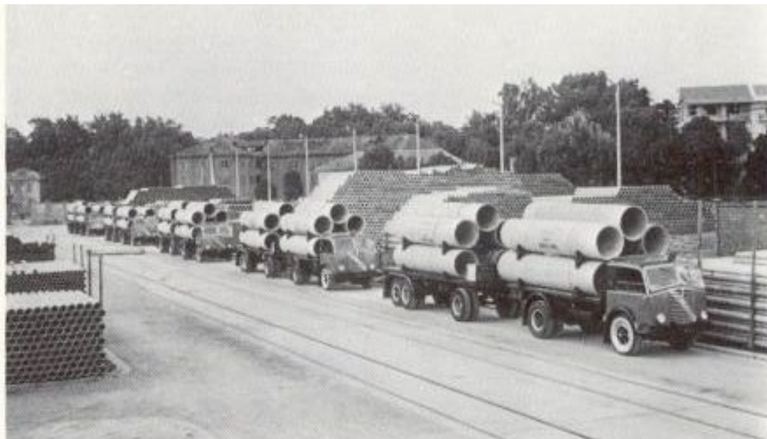
Immagine n°5 – Il trasporto delle tubazioni in passato (fonte: letteratura di settore)
